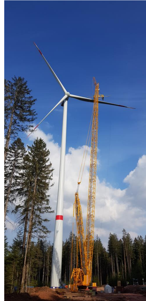
WEA 2 errichtet (April 2021)
