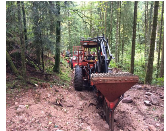
Verlegung Kabeltrasse
